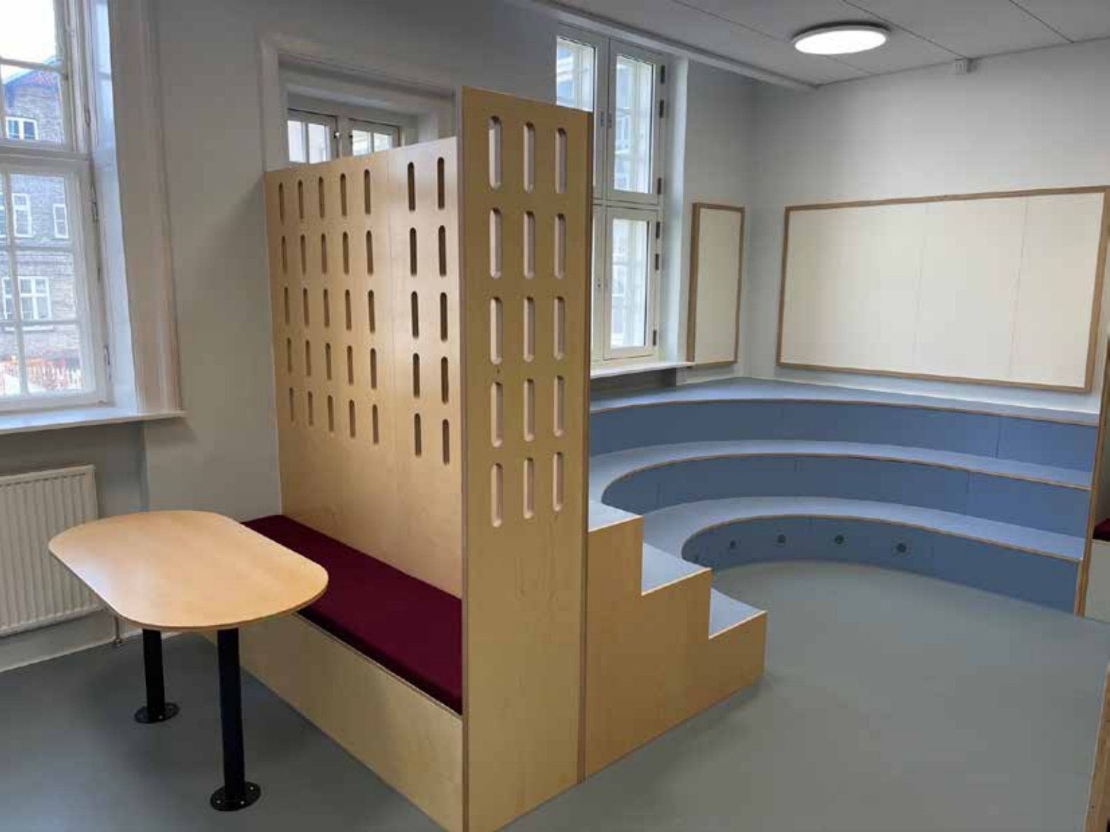
Rosenvænget Specialskole 2024, innebygd skjermet bord og benker utført i kryssfiner med polstring
