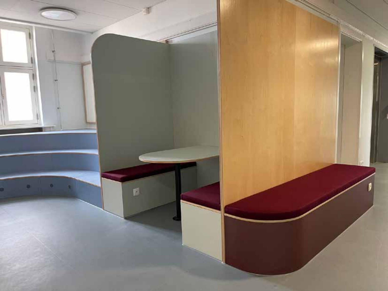
Rosenvænget Specialskole 2024, innebygd og skjermet bord- og benkesett med avrundede hjørner og farget laminat samt polstring
