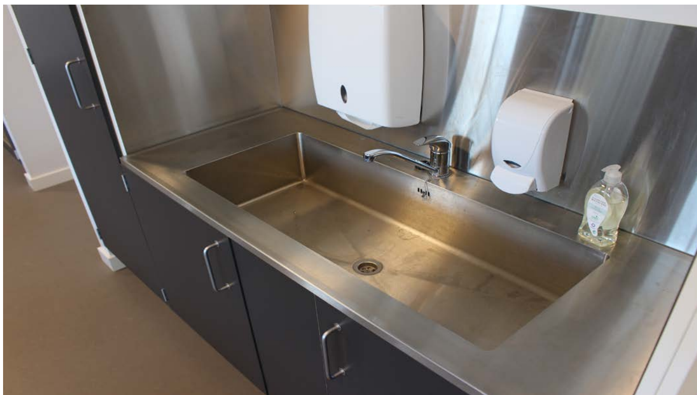
Funksjonell vask med stålbackvegg.
